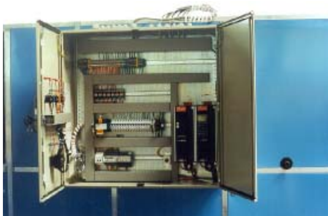
Шкаф управления, смонтированный на вентиляционной установке.
