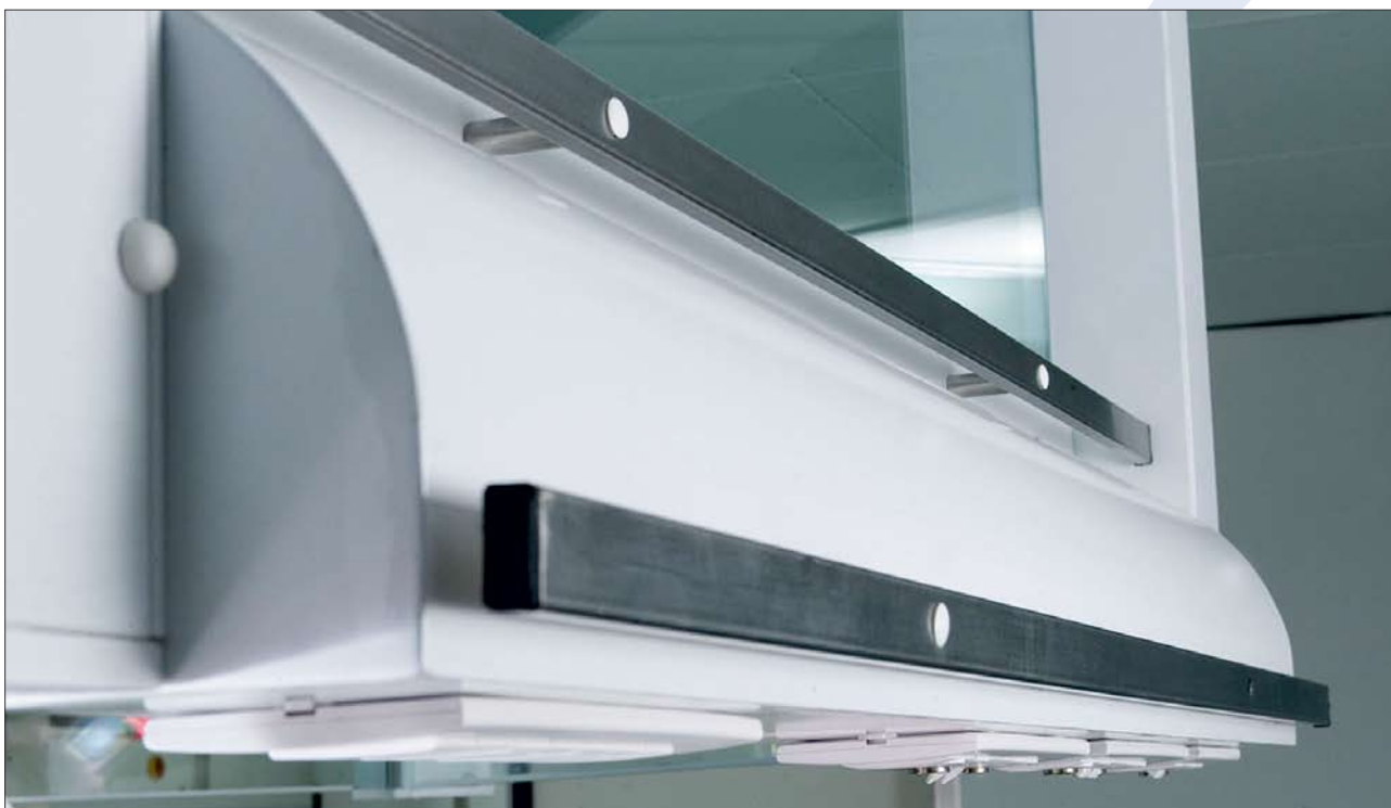
Рис. 19. Медиа консоль с DIN-рейкой
