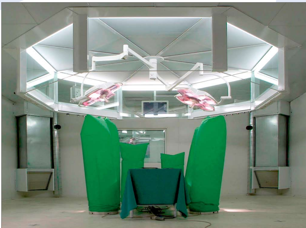
Рис. 13. Ламинарный потолок. Общий вид
